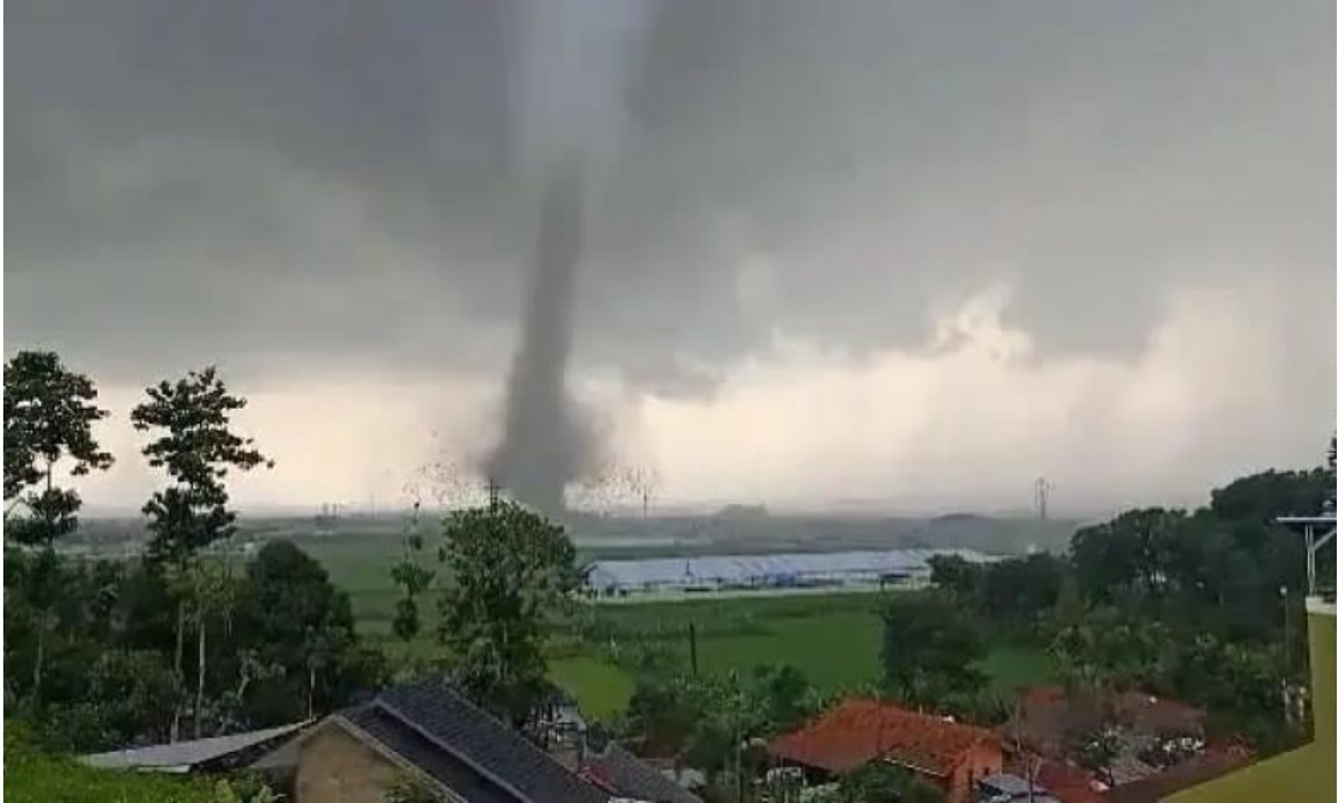
Gambar 5.1 Angin puting beliung melanda Kecamatan Rancaekek dan Jatinangor menyebabkan kerusakan signifikan pada pemukiman warga dan infrastruktur industri (Sumber: HeraldJabar)
